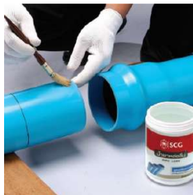
รูปที่ 4.17 แสดงการทาน้ำยาหล่อลื่นท่อก่อนการสวม (ที่มา : ท่อเอสซีจี)
