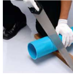
รูปที่ 4.13 แสดงการวัดระยะและตัดท่อแหวนยาง (ที่มา : ท่อเอสซีจี)
