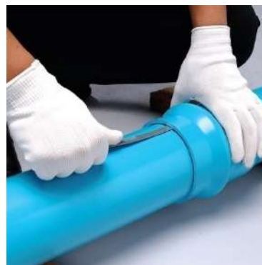
รูปที่ 4.19 แสดงการใช้เกจวัดตรวจสอบตำแหน่งแหวนยาง (ที่มา : ท่อเอสซีจี)
