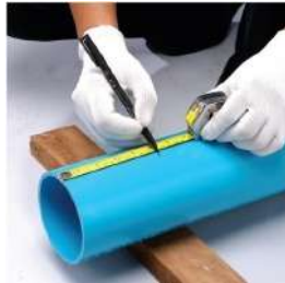
รูปที่ 4.13 แสดงการวัดระยะและตัดท่อแหวนยาง (ที่มา : ท่อเอสซีจี)
