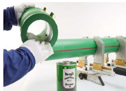
รูปที่ 4.26 แสดงการปอกผิวท่อ และเช็ดทำความสะอาดท่อและข้อต่อพีพีอาร์ (ที่มา : ท่อเอสซีจี)
