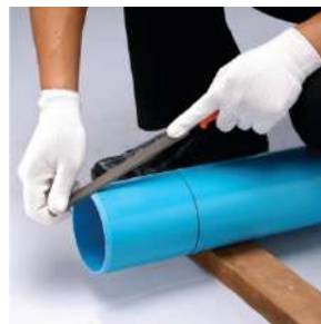
รูปที่ 4.14 แสดงการใช้ตะไบละเอียดลบมุมที่ปลายท่อ (ที่มา : ท่อเอสซีจี)
